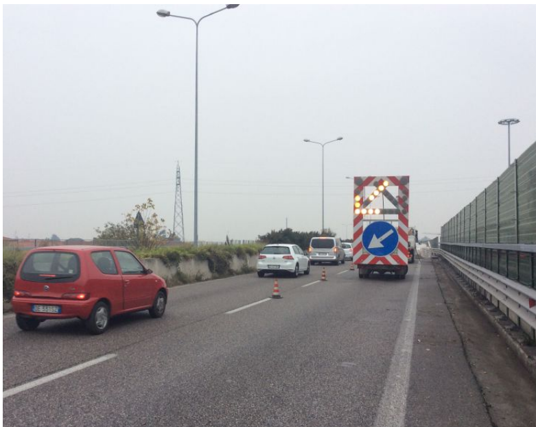
Le code che da martedì rallentano la circolazione al ponte di Curnasco
